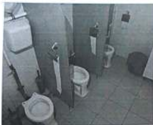
Фото №32 - Санитарно-гигиенические помещения
