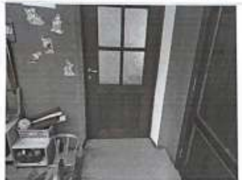
Фото №21 - Пути движения внутри здания (местный)
