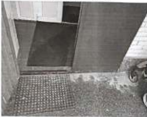
Фото №9 - Высота входной двери главного входа
