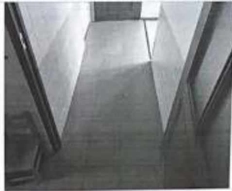
Фото №20 - Пути движения внутри здания (местный)
