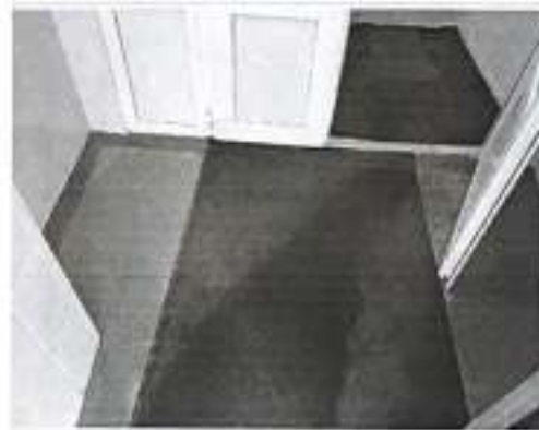
Фото №10 - Тавёр. Внутренняя высота двери главного входа
